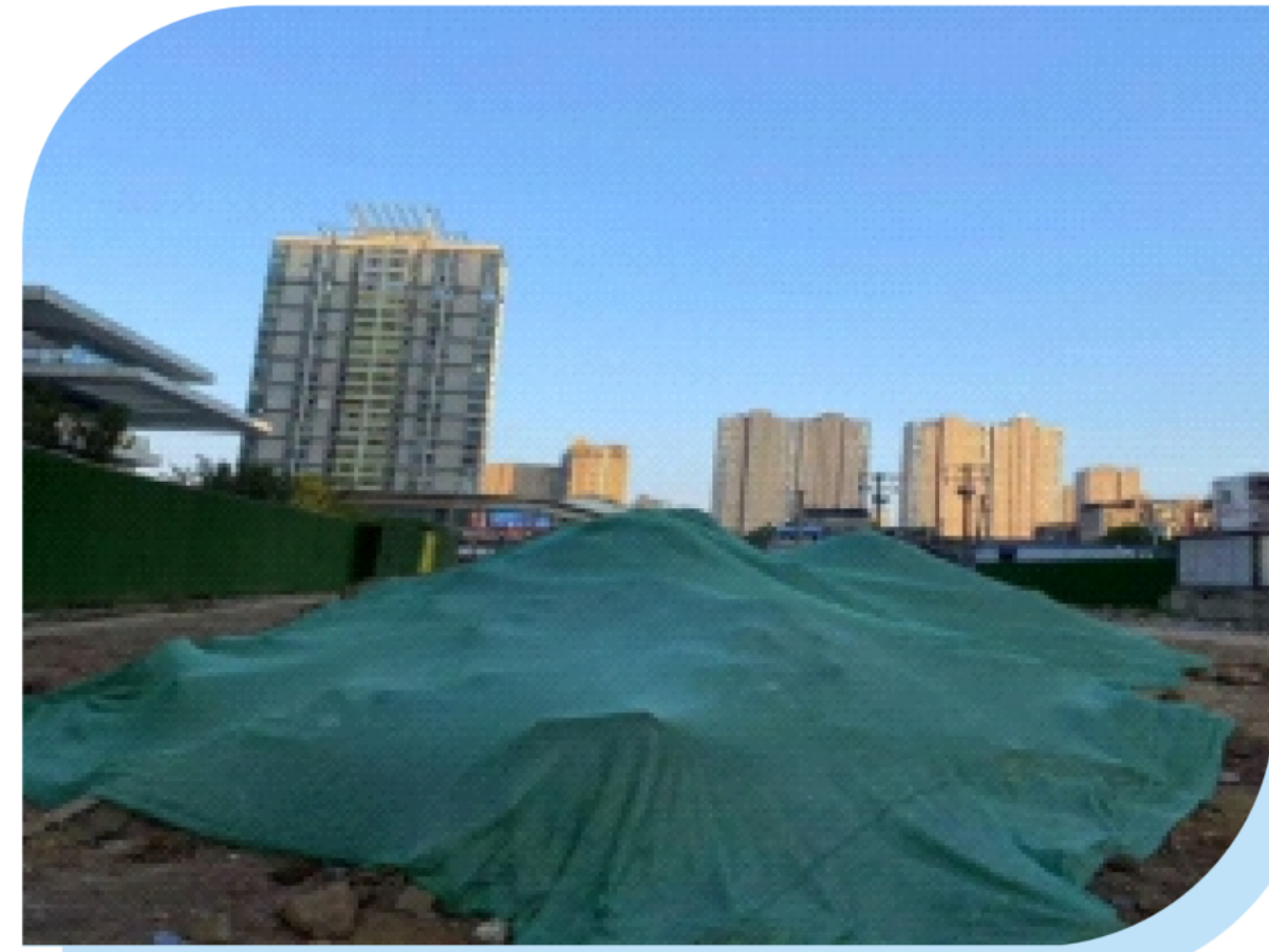
临时苫盖 纬四路（临江大道-和平大道）工程
