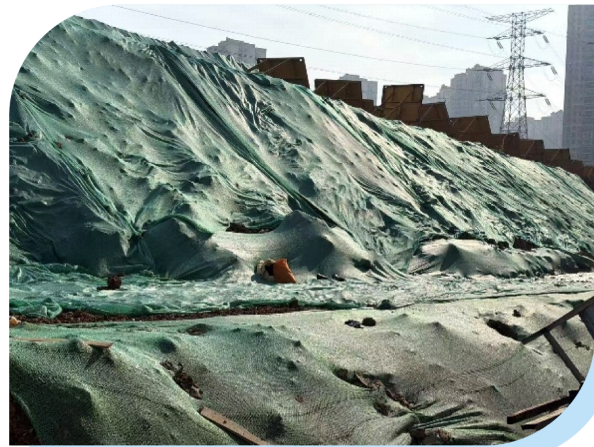
临时苫盖 新建居住、商业、商务、中学（复合公交首末站）项目
