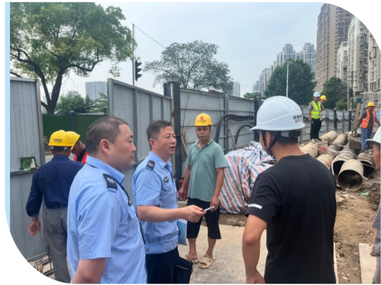
湖北省武昌实验中学新建教学楼项目
