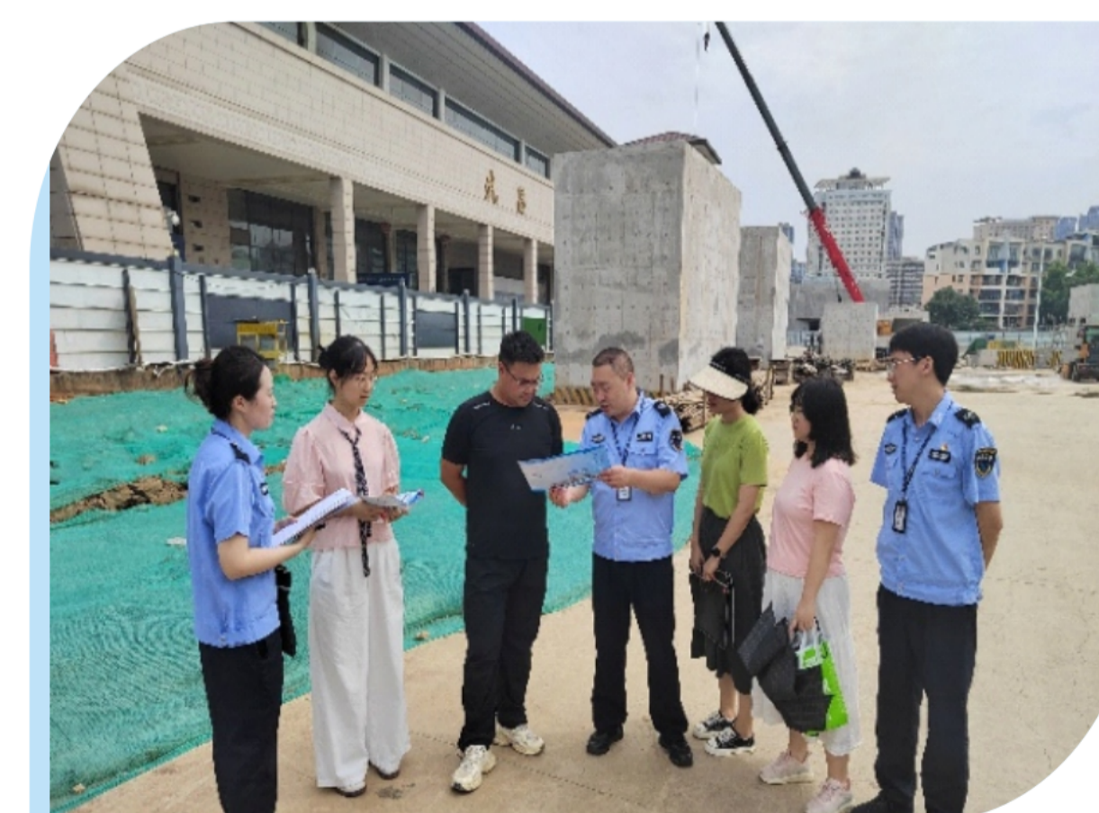
武汉市轨道交通12号线(武昌段)工程
