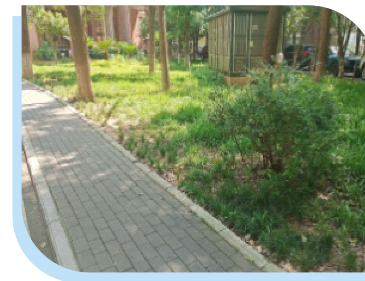
人行道透水砖 南湖地区海绵城市建设改造工程
