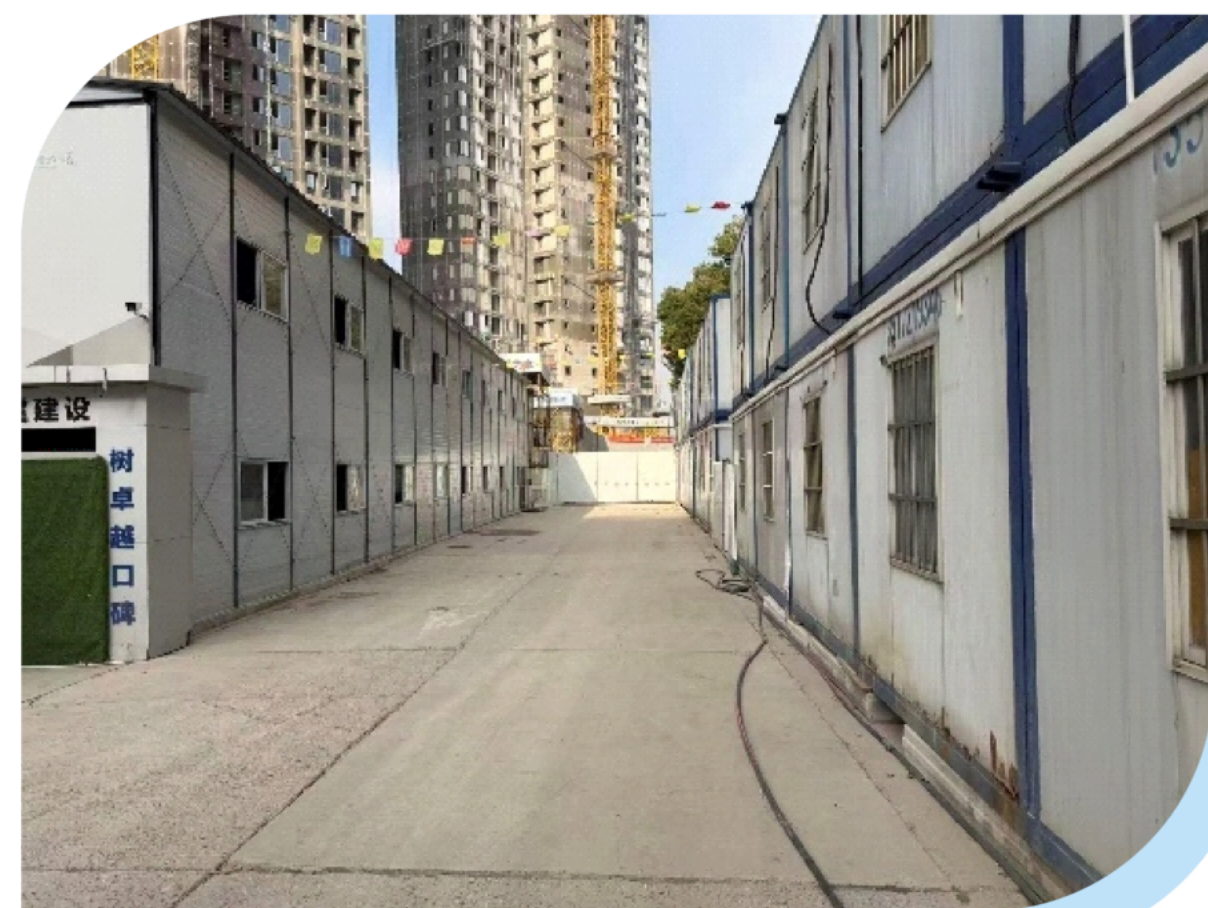
临时施工道路 余家湖村城中村改造产业用地C地块（保障性租赁住房）建设项目
