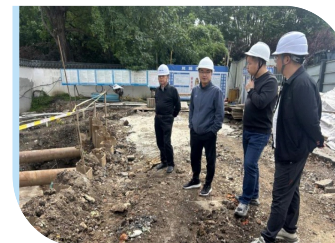
紫阳湖第二排水通道工程
