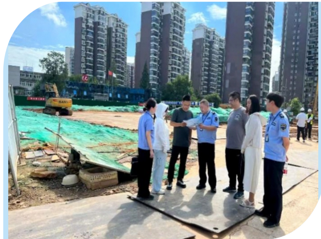
武汉市十五中地下停车场工程
