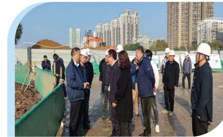
巡司河泵站及配套工程
