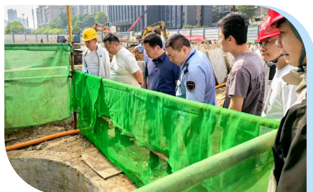
地铁12号线四标段公正路站项目
