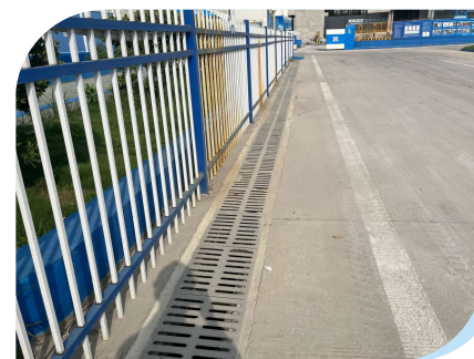
临时排水沟——联投中心项目（二期）项目
