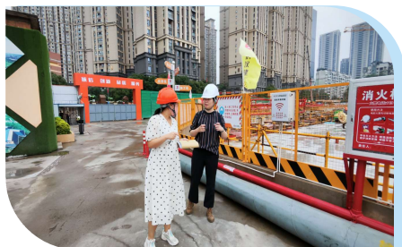
武汉市武昌医院东区门诊住院综合楼（平疫结合）项目
