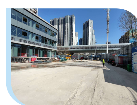
道路硬化——余家头校区 交通协同创新基地项目
