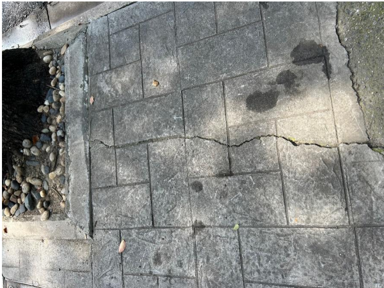
人行道现浇砼断裂、剥落
