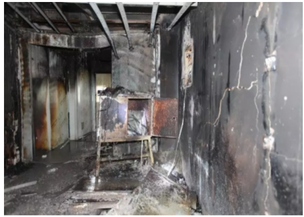
图6 配电箱底部可燃物被烧毁（由西向东）
