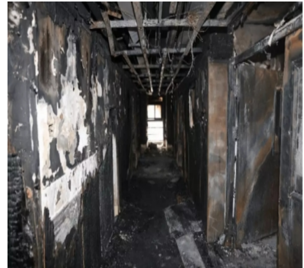
图8 南通道六层墙面过火情况（由东向西）
