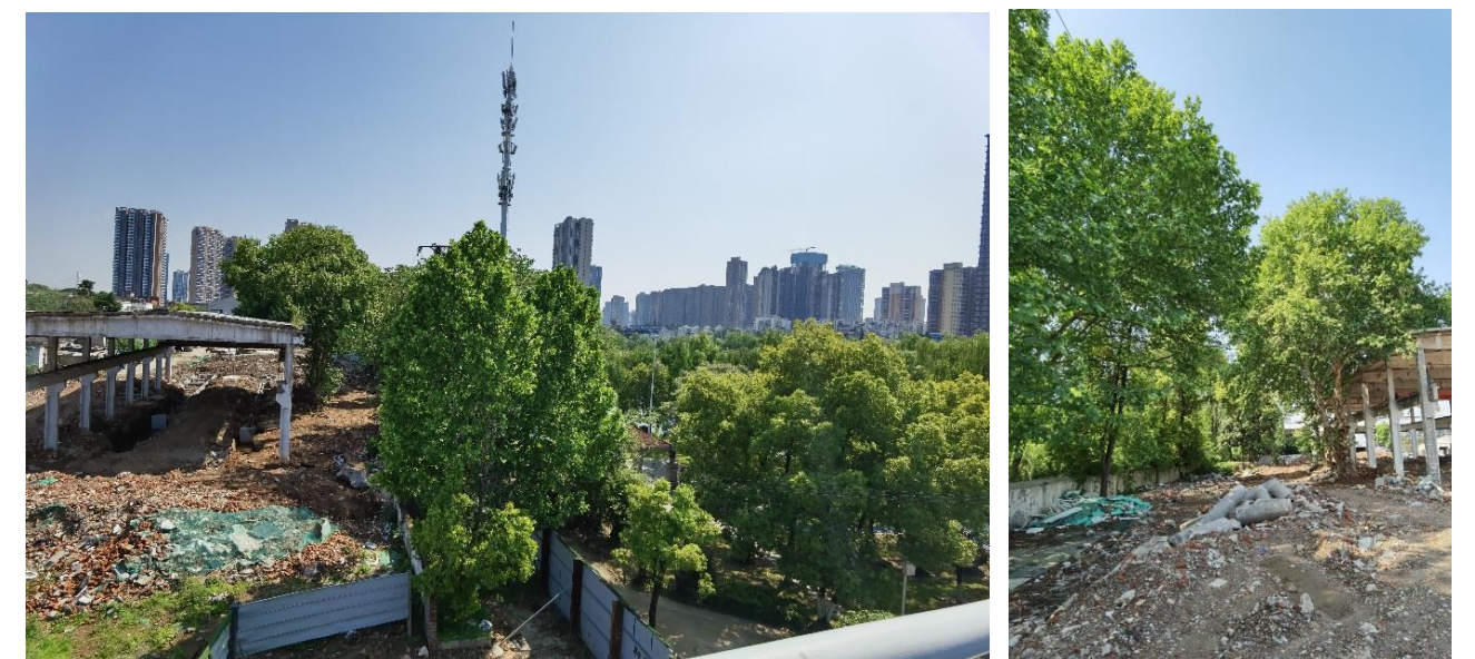
徐美东路起点区域现状情况
