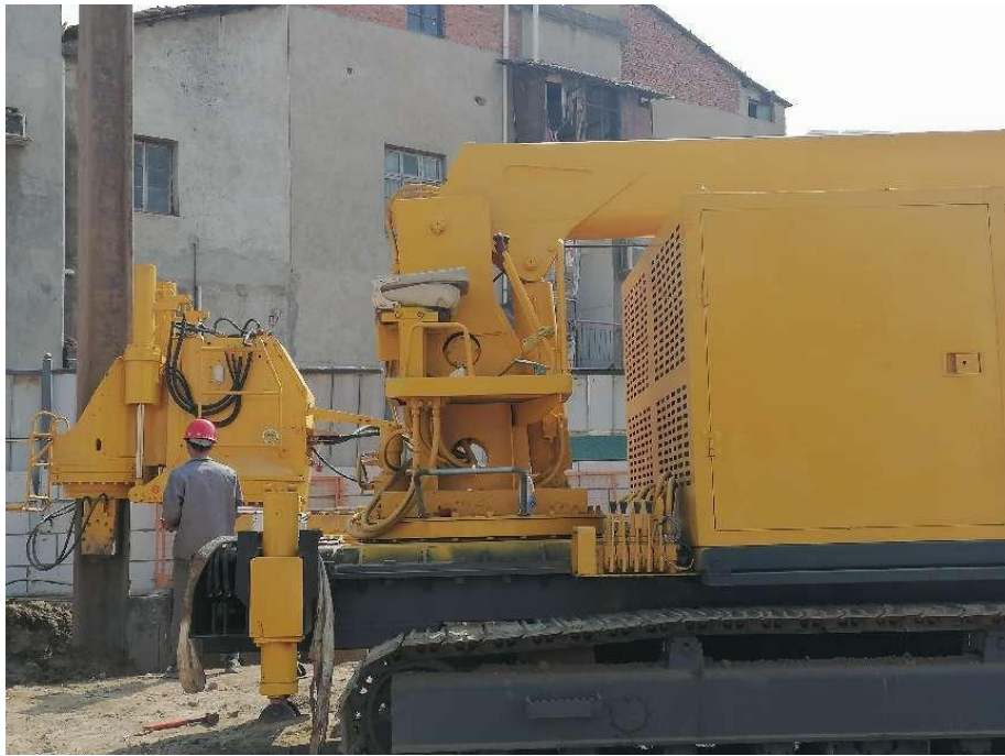
临近现状房屋的钢板桩静压施工实拍图
