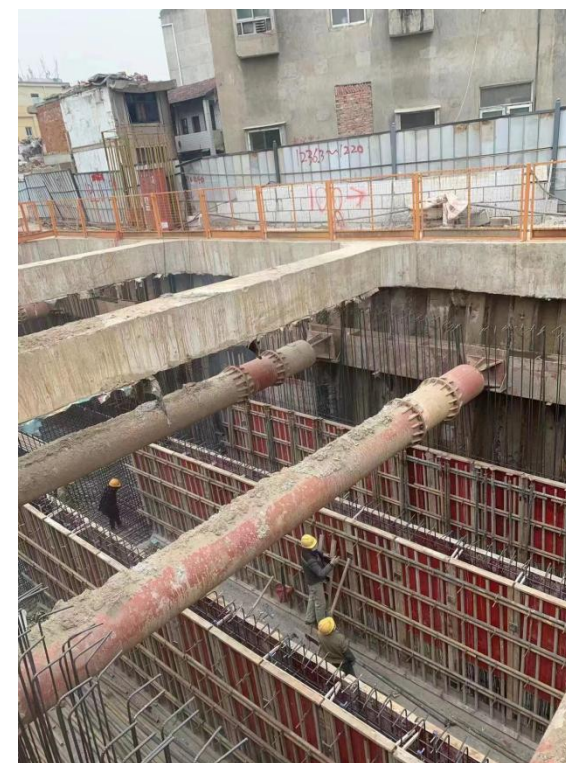
钢板桩+冠梁+混凝土支撑实拍图
