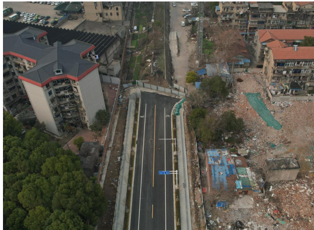
现状丰收路道口
