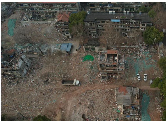
在建武船二分厂改造地块拆迁区
