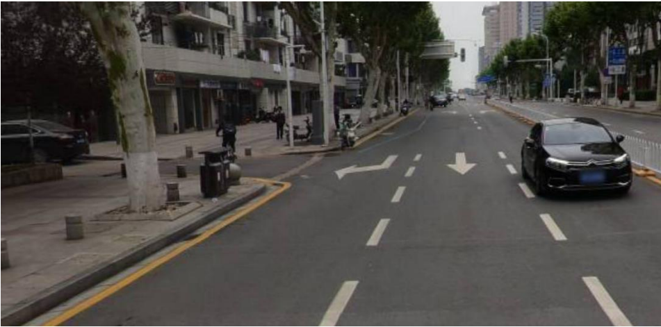
东一路道口展宽段挤占非机动车道
