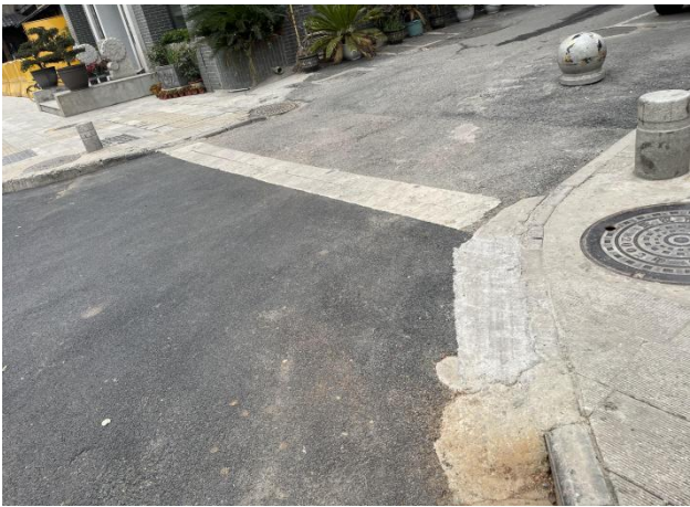
无障碍处水泥抹顺
