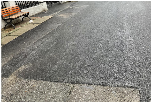
工程止点接现状沥青加铺层
