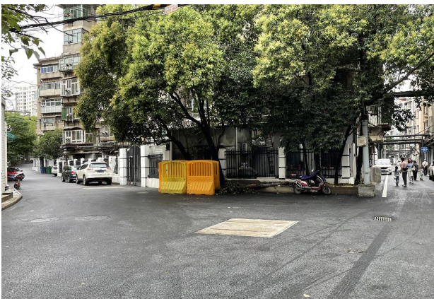
南苑村段已路面改造完
