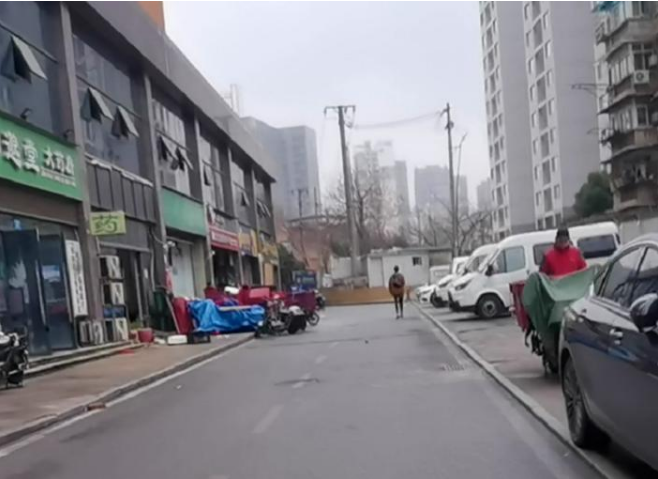
现状架空杆线
